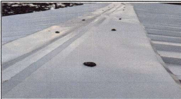
Foto 3: Sustitución de capotes de lámina para lámina troquelada
