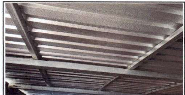
Foto 6: Sustitución de estructura de techo soporte de manera por metal
